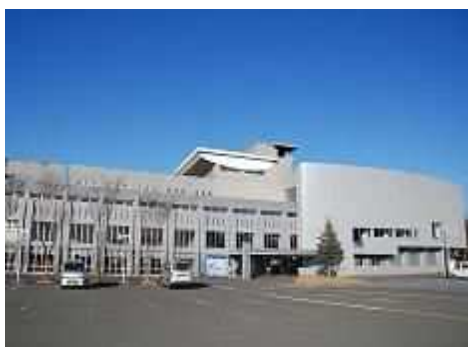
※写真は敷島総合文化会館
